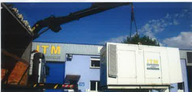
Manutention groupe électrogène
